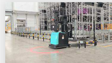
自動倉庫との接続
